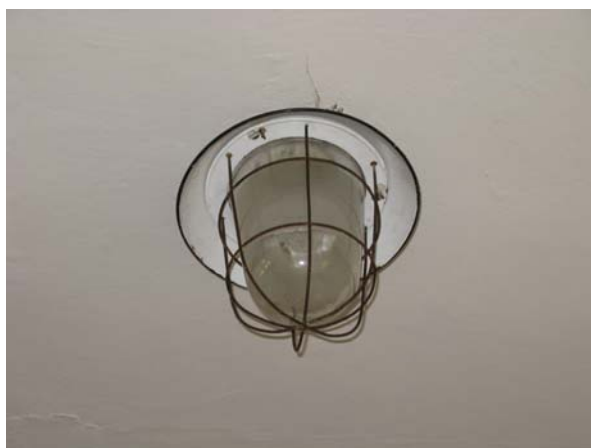
Nevhodné a ne hospodárne žiarovkové svietidlá s difúzorom – vľavo v kuchyni a odbornej učebni, vpravo v triede
