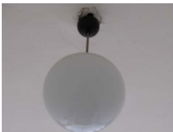
Nevhodné a ne hospodárne žiarovkové svietidlá s difúzorom – vľavo v kuchyni a odbornej učebni, vpravo v triede
