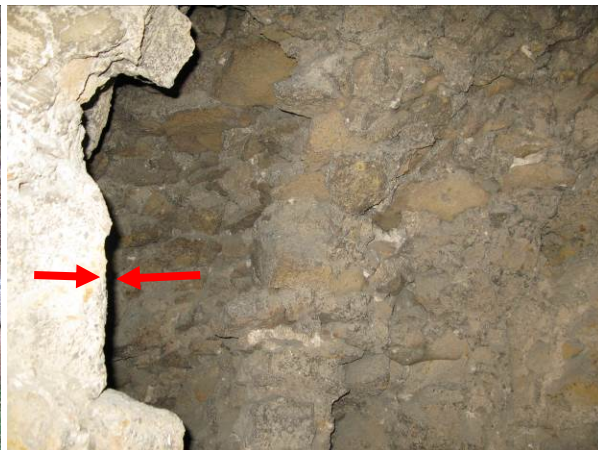
foto 45 Rozhranie murív veže, vpravo sekund. plášť
