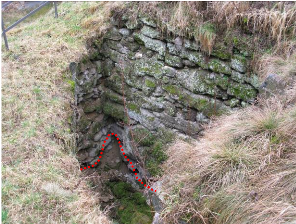
foto 20 Odkryté základové murivo
