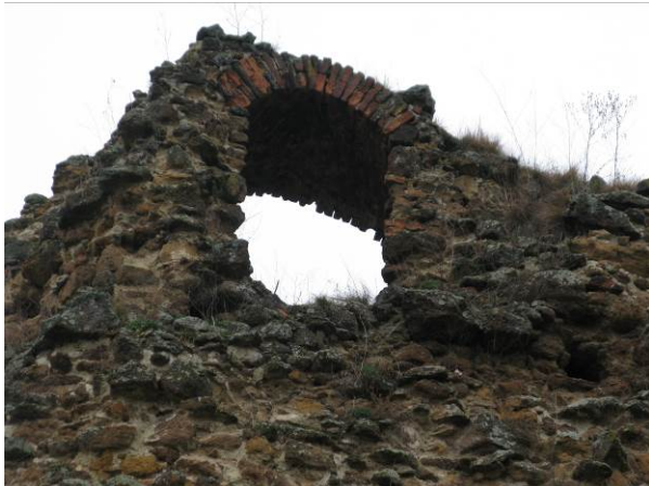
foto 40 Záklenok otvoru A – interiér
