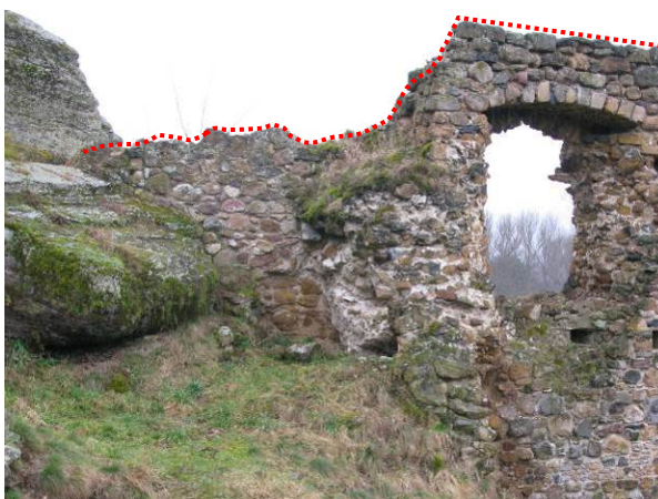
foto 11 Torzo steny výťahu - interiéru
