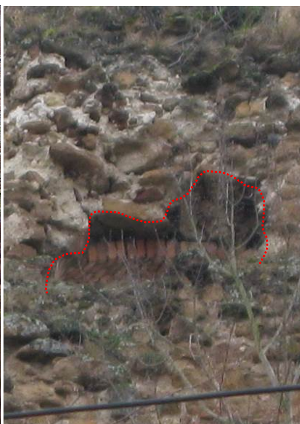
foto 29 Detail plášťa nad strieľňou
