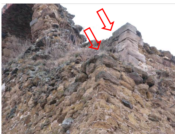
foto 43 Detail vrstvenia murív, južné nárožie
