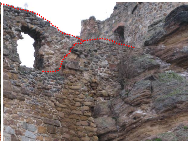
foto 14 Torzo steny výťahu – exteriér
