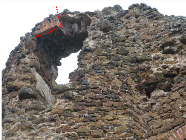
foto 41 Záklenok otvoru B – interiér
