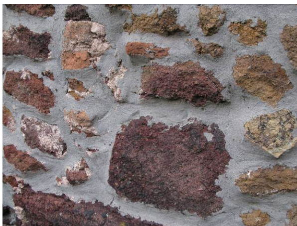
foto 48 Pôv. murivo preškárované cementovou maltou
