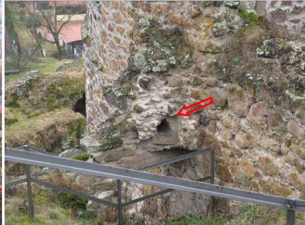
foto 33 Kamenársky prvok odtokového žľabu
